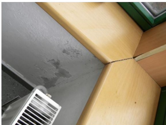
obr. zatékání do konstrukce (zdroj: pracovní fotodokumentace projektanta)
