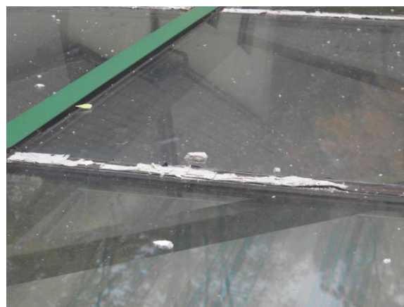
obr. "vypadnutí" zasklení, nefunkční příčné spoje zasklení (zdroj: pracovní fotodokumentace projektanta)
