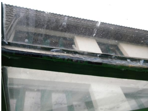
obr. "vypadnutí" zasklení, nefunkční příčné spoje zasklení (zdroj: pracovní fotodokumentace projektanta)
