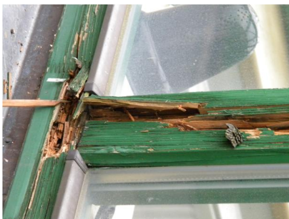
obr. degradace dřevěných prvků - ext. (zdroj: pracovní fotodokumentace projektanta)
