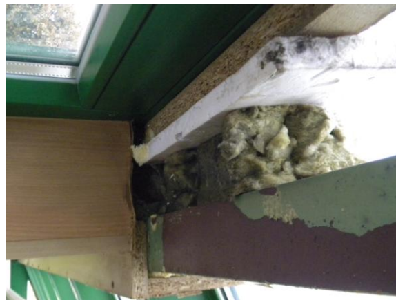
obr. zatékání do konstrukce (zdroj: pracovní fotodokumentace projektanta)
