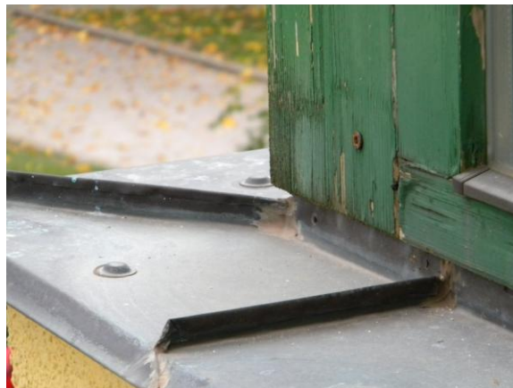
obr. poruchy u vstupu (ext. schodiště) a parapetu (zdroj: pracovní fotodokumentace projektanta)
